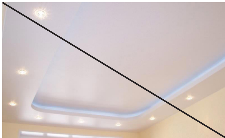
Плохо Многоуровневые гипсокартонные конструкции
